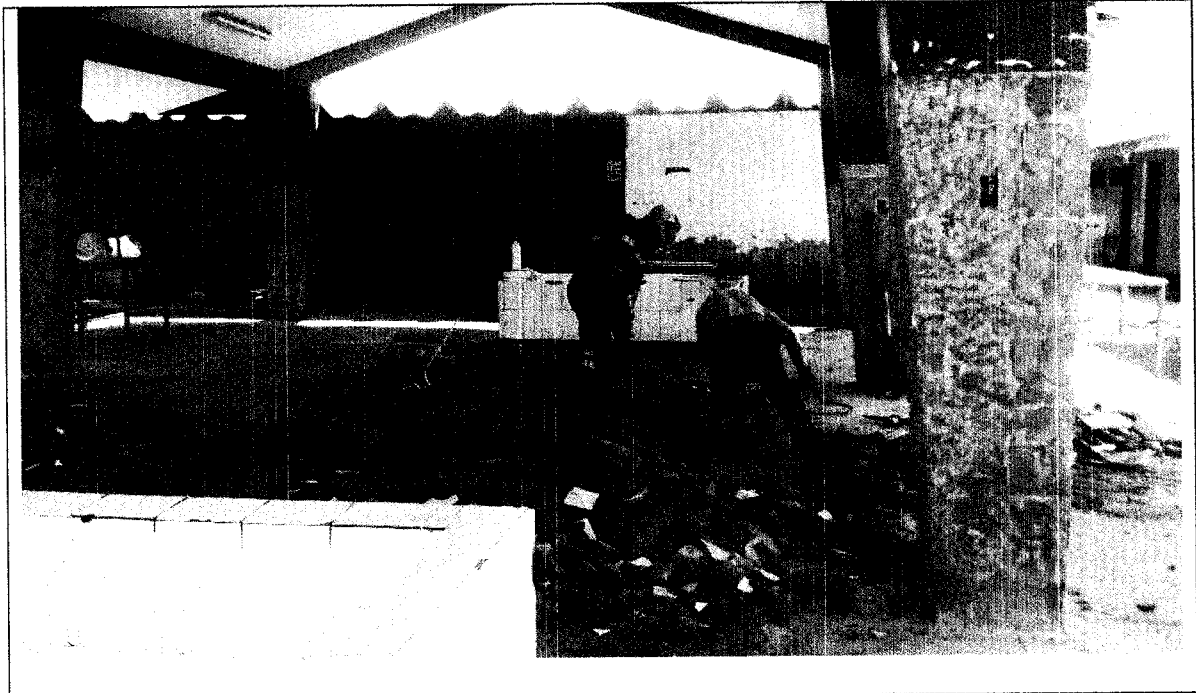
Imagen N° 09: En la presente imagen se puede observar los trabajos de demolición de estructuras deterioradas pozas de concreto en sala de manipuleo.
